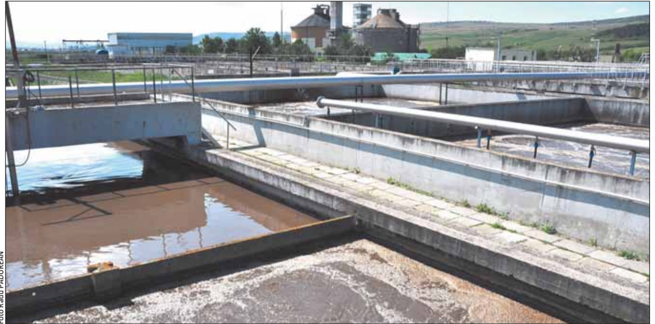
Lucrările de modernizare și extindere a stației de epurare din Someșeni vor dura 21 de luni
