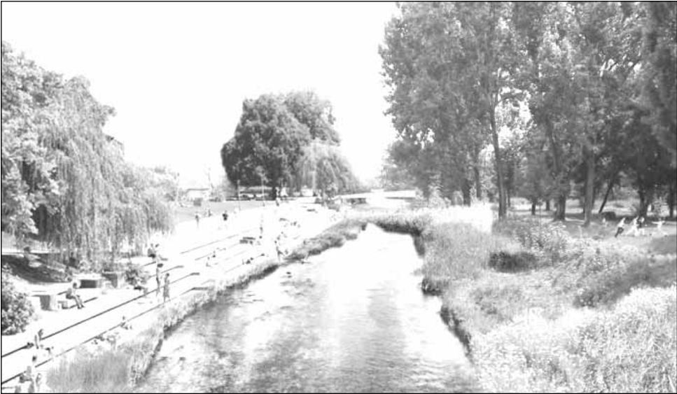
Începând din primăvara anului viitor se vor vedea primele lucrări pe două sectoare ale Someșului
