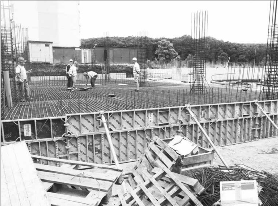
Din toamna anului 2013, de când a început șantierul și până acum, lucrările nu au avansat foarte mult
