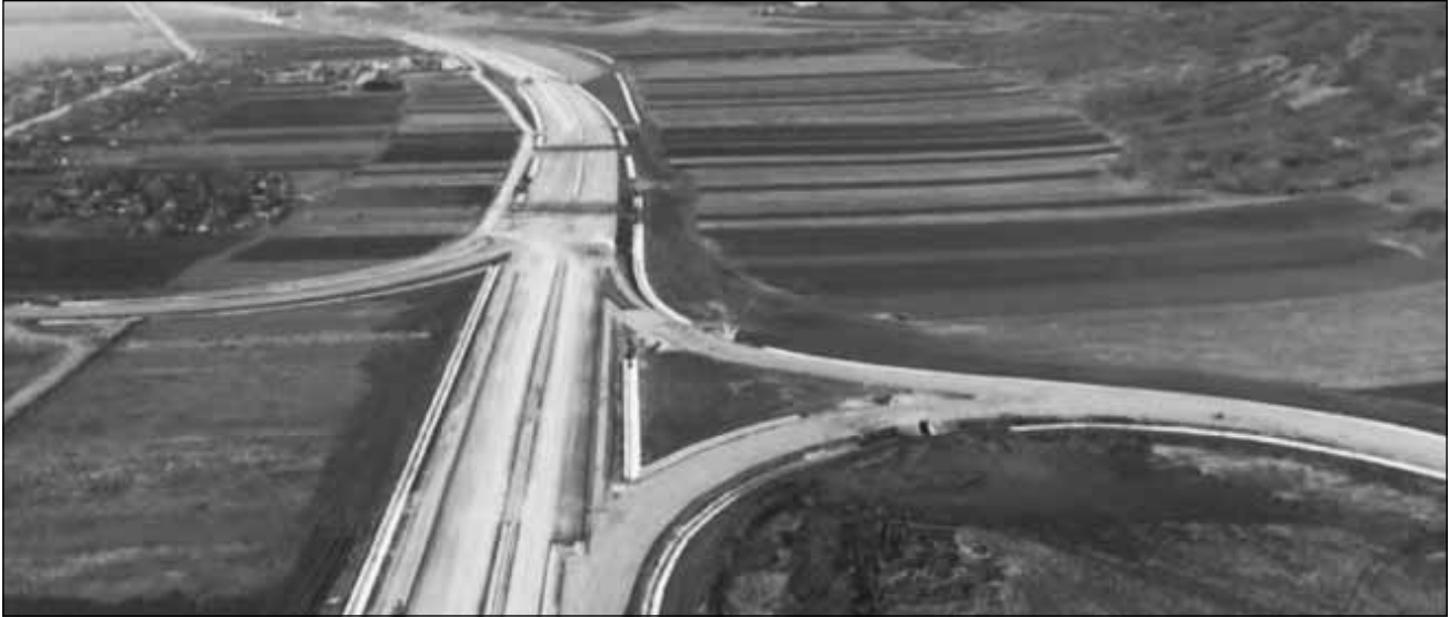
Imaginile cu Autostrada Sebeș-Turda, filmate cu drona, surprind avansul lucrărilor
