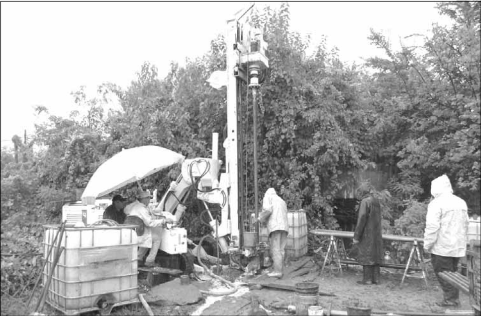
Echipele tehnice se vor deplasa în zonele studiate pentru a efectua lucrările de foraje geotehnice aferente proiectului metrou în Cluj
