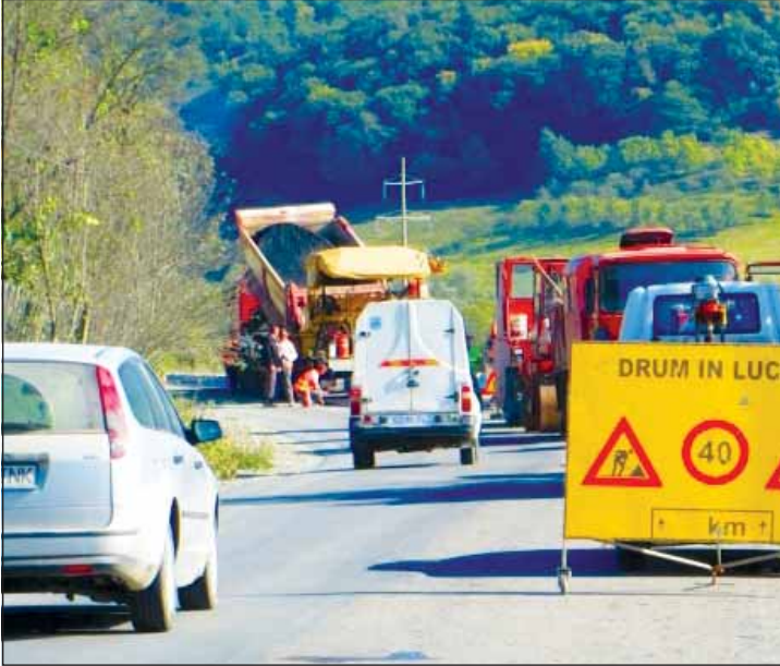
Pe zeci de tronsoane vor începe lucrările de reabilitare
