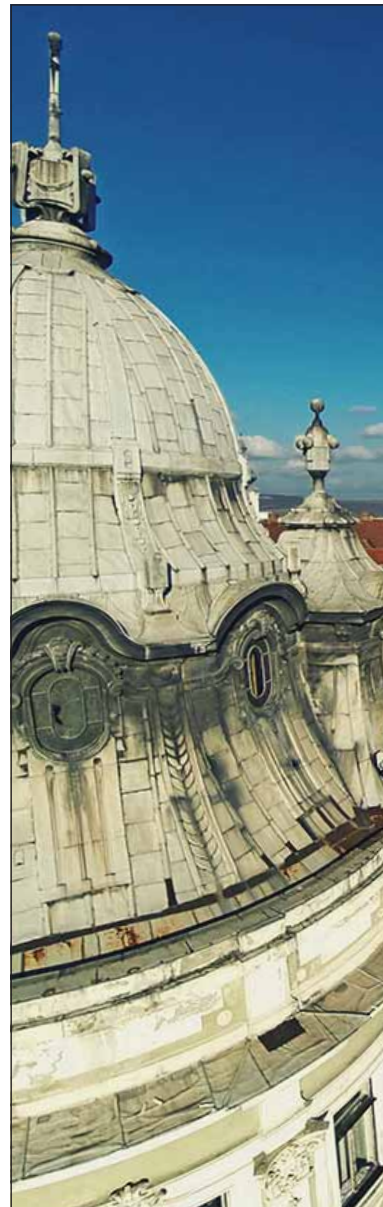
Stilul arhitectonic al celor două clădiri în o
