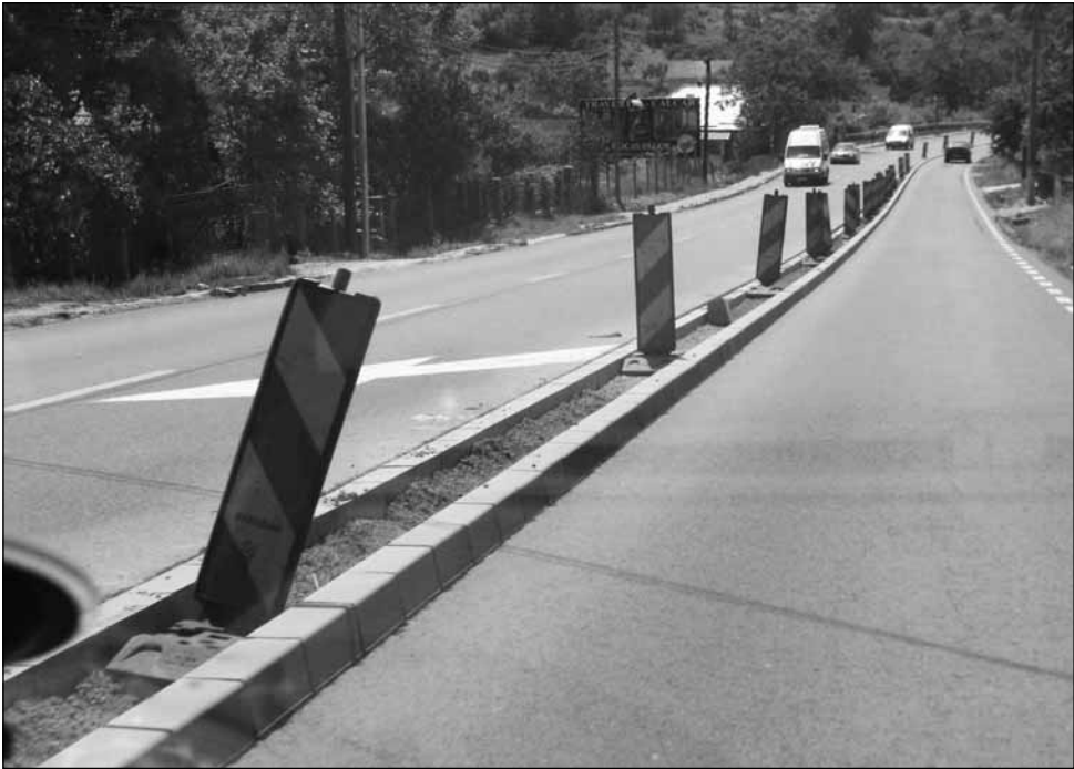
Lucrările la separatoarele de sens sunt într-un stadiu avansat
