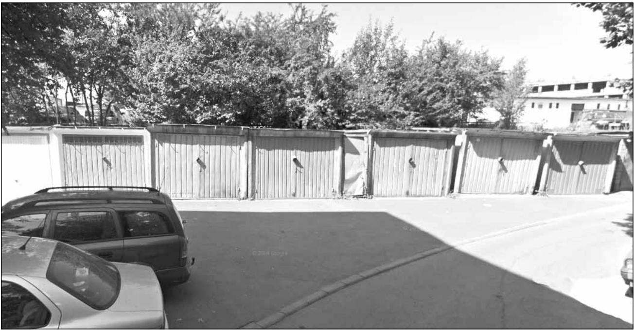
Garajele stau goale sau sunt folosite pe post de depozit pentru murături, iar mașinile stau parcate pe trotuar
