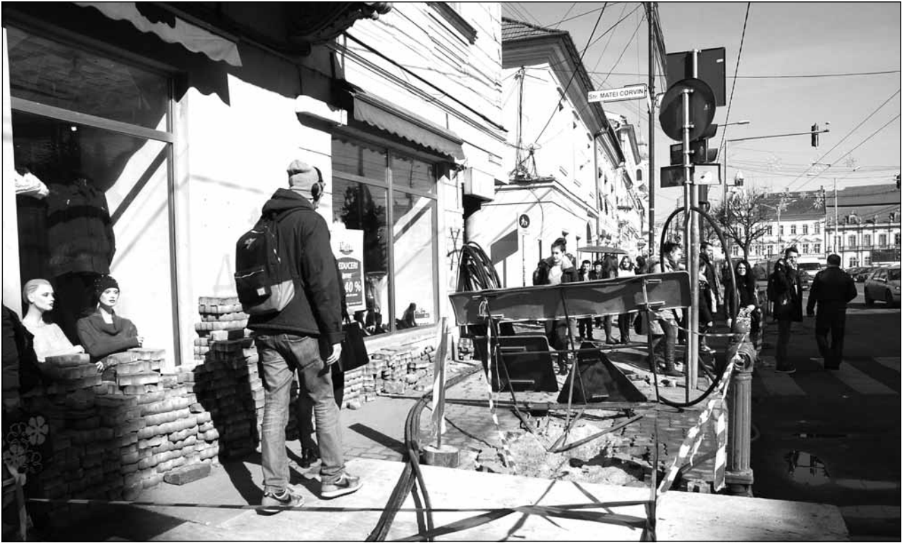
Pe trotuarul de pe strada Memorandumului se desfășoară un adevărat șantier
