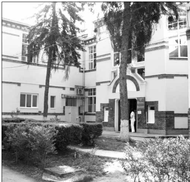
Spitalul de Pneumoftiziologie „Leon Daniello” va fi dotat cu aparatură medicală ultramodernă
