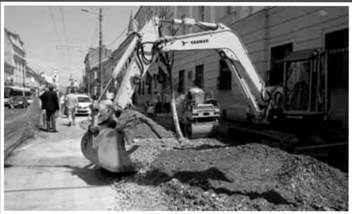
În cazul unor străzi, termenul de finalizare a lucrărilor a fost depășit
