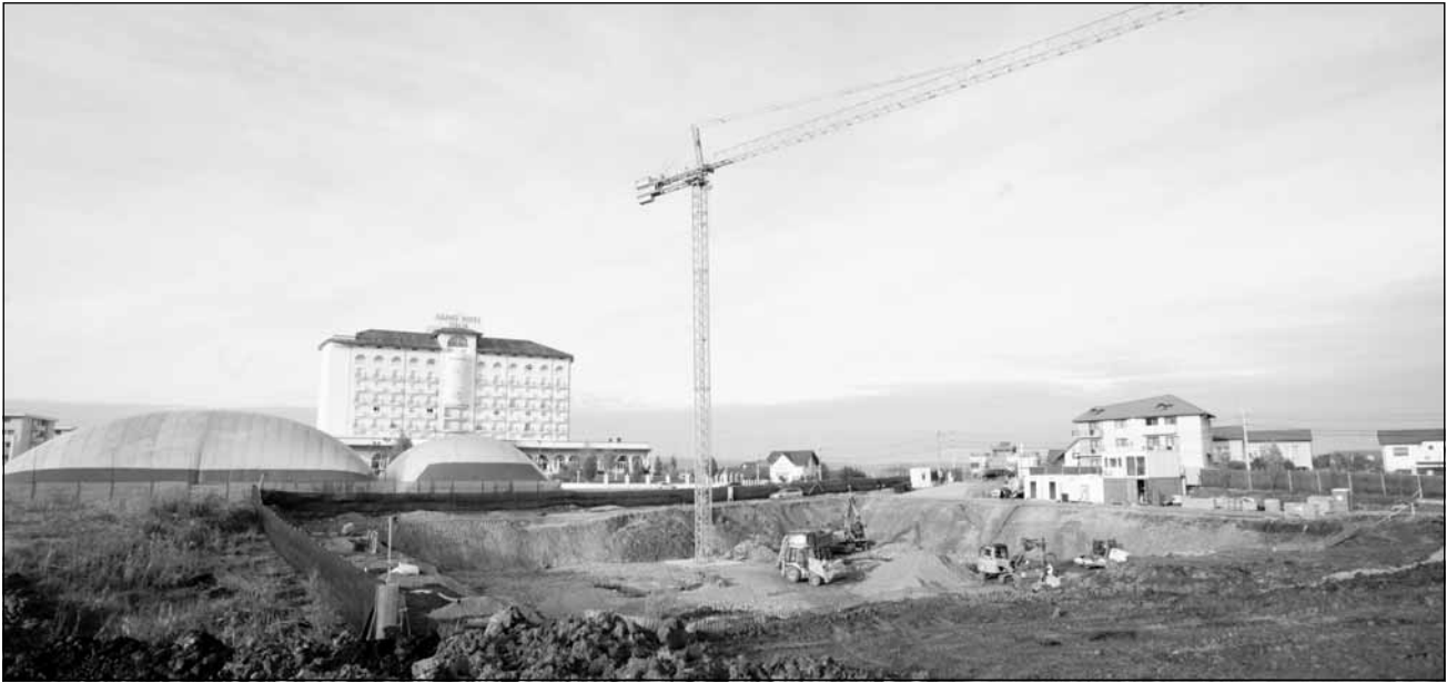
Pe șantierul de pe strada Trifoiului se lucrează de zor cu cel puțin șase utilaje
