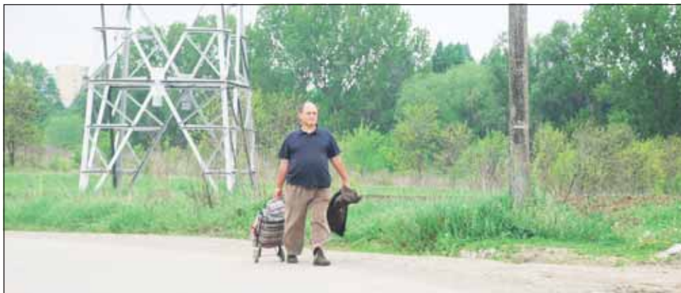
Pe Strada Soporului, cea mai lungă din oraș, nu există nici asfalt, nici canalizare și nici iluminare publică
