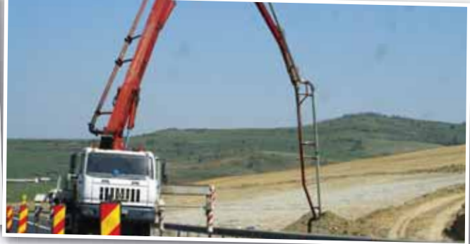
Lucrări la km 277
