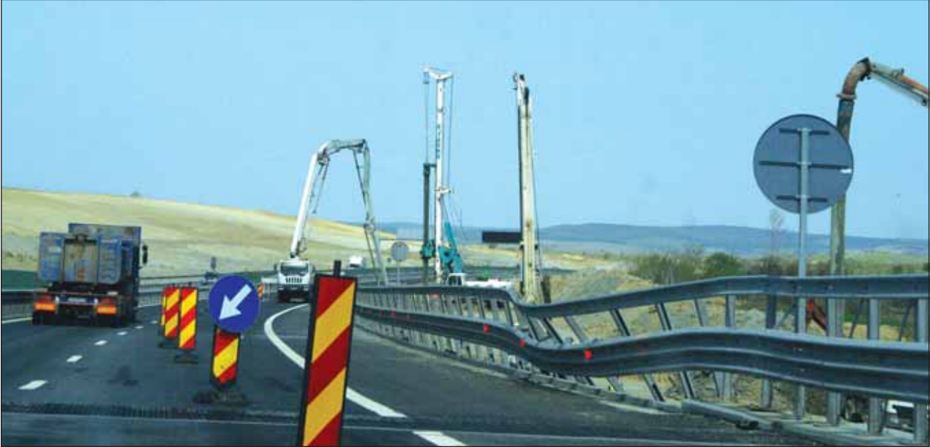
Injectările au rolul de a stabili fundaamentul
