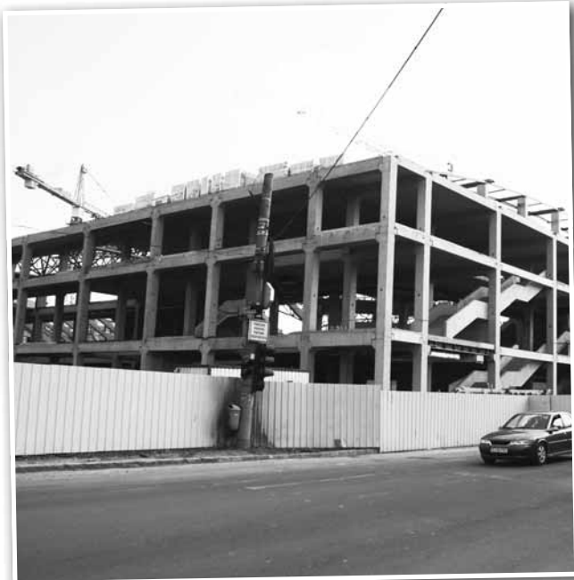
Lucrările au avansat. Astfel arăta șantierul Sălii Polivalente în 2012
