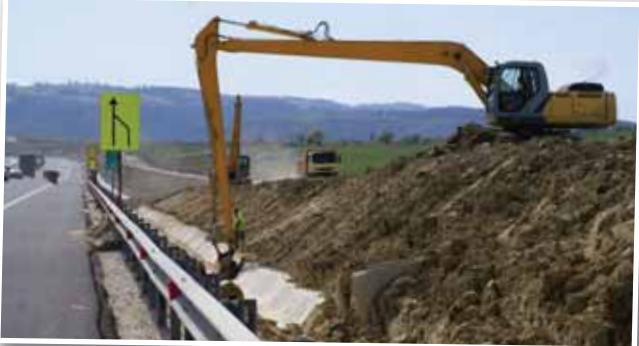
La km 276, se lucrează intens, iar viteza este restricționată la 60 km/h
