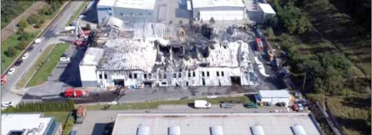
O hală de aproximativ 600 de metri pătrați a luat foc, marți dimineața, în zona Tăietura Turcului, fiind nevoie de intervenția mai multor echipaje de pompieri
