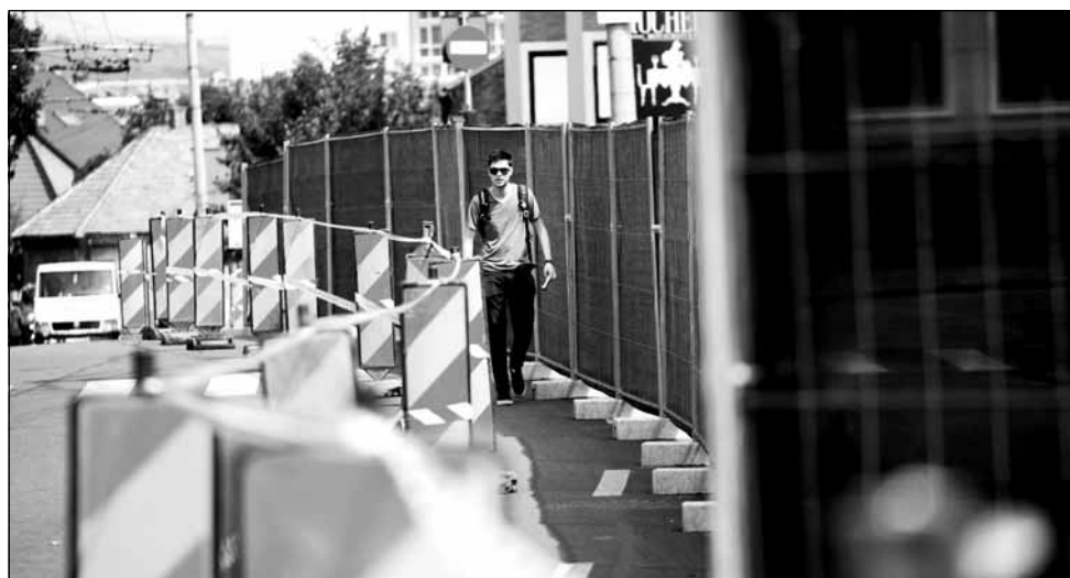
Zona podului Traian a fost delimitată luni dimineața cu garduri
