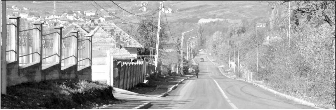
Primăria a spus la începutul anului „stop joc” construcțiilor în cartierul Borhanci după ce studiile au arătat o depășire cu 126% a traficului
