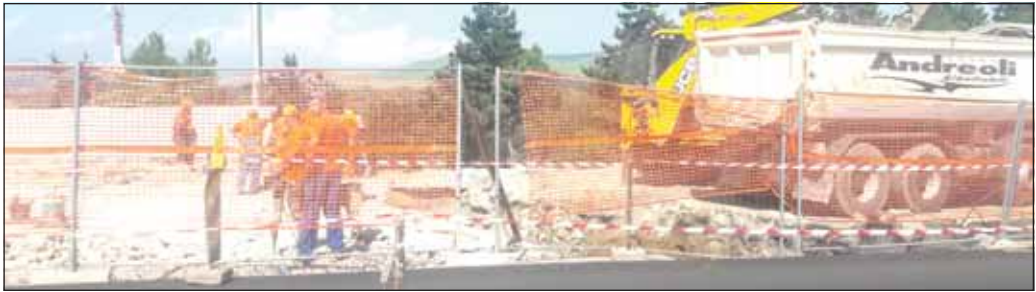
La podul N, muncitorii lucrează pe banda dintre Grigorescu spre Mănăstur
