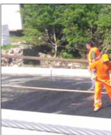
Lucrările la suprastructura podului peste So
