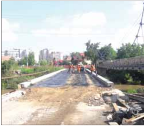
Podul peste Someș de pe strada Fabricii
