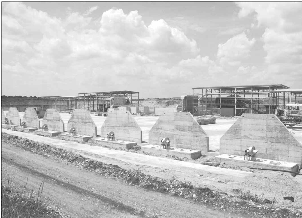
Centrul de Deșeuri se construiește de 6 ani, în prezent fiind o ruină care a costat județul peste 100 de milioane €
