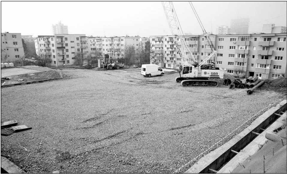
Utilajele lucrează de zor la Parkingul de pe strada Primăverii nr. 20
