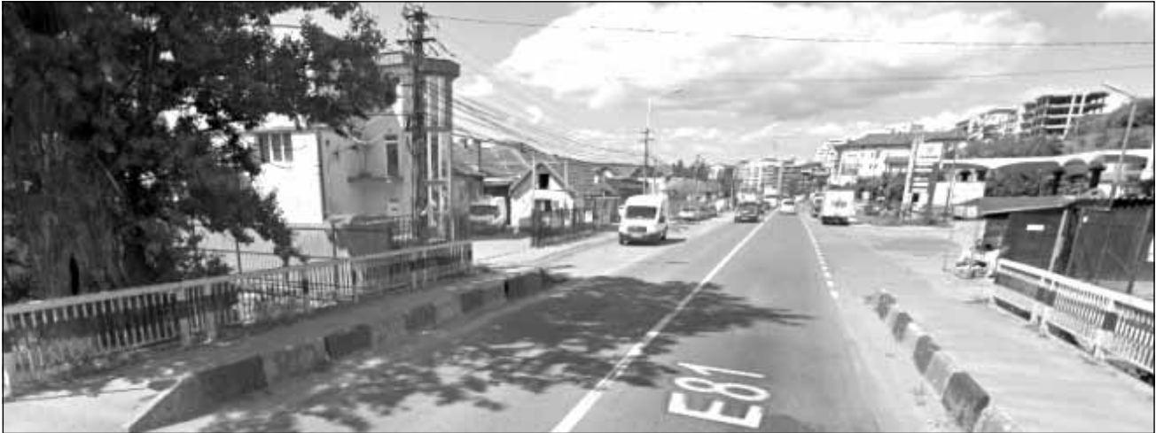
Podul de pe Calea Baciului va fi lărgit la patru benzi
