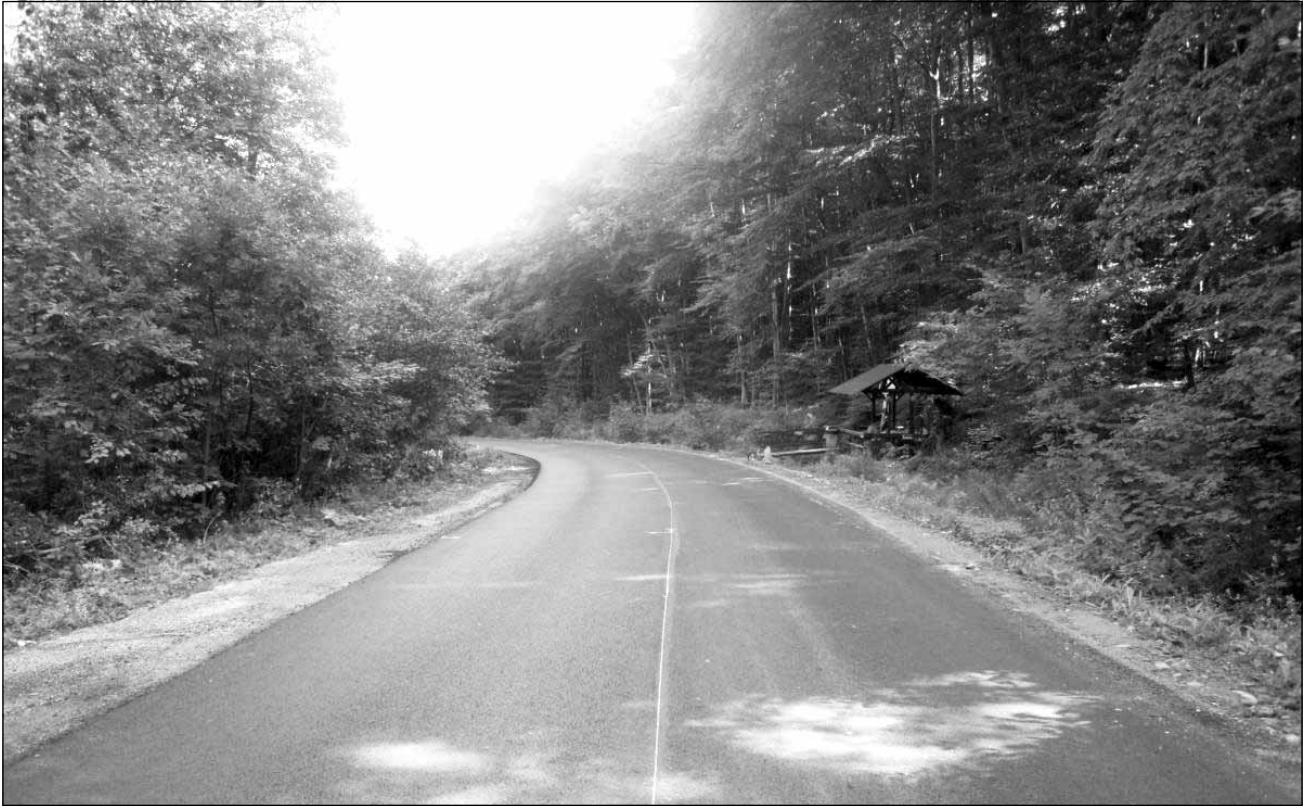
În lipsa unei centuri ocolitoare, traficul rutier în afara orașului se poate face în cel mai bun caz pe drumuri comunale
