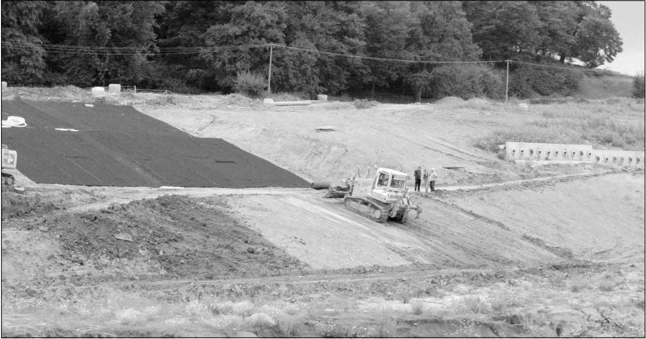
Parcul Industrial Tetarom I s-a extins cu 16,8 hectare, dar deocamdată nu se poate face recepția totală a clădirilor din cauza alunecărilor de teren
