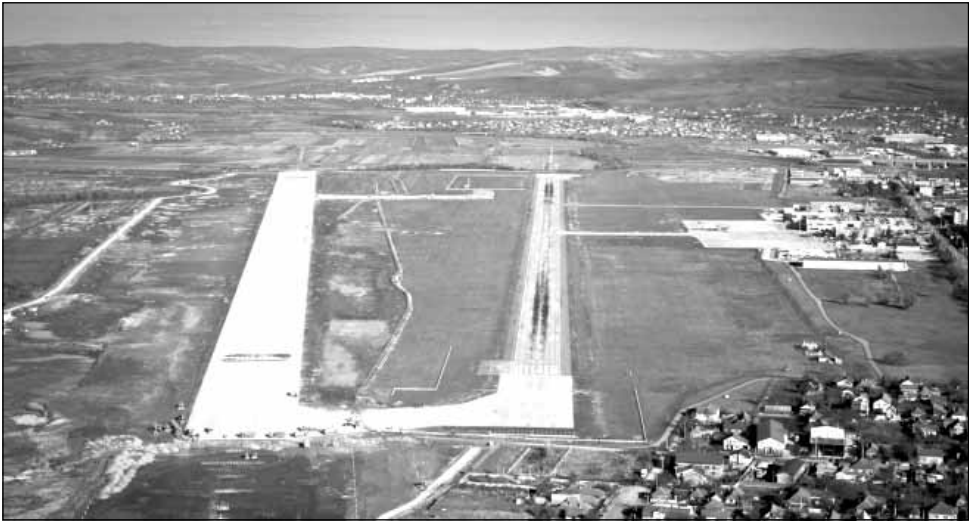
În 2013, Consiliul Județean Cluj finaliza lucrările de construire a noii piste de decolare-aterizare de 2100 metri
