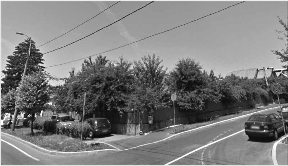
Un bloc de șase etaje va fi construit la intersecția străzilor Corneliu Coposu și Porumbului
