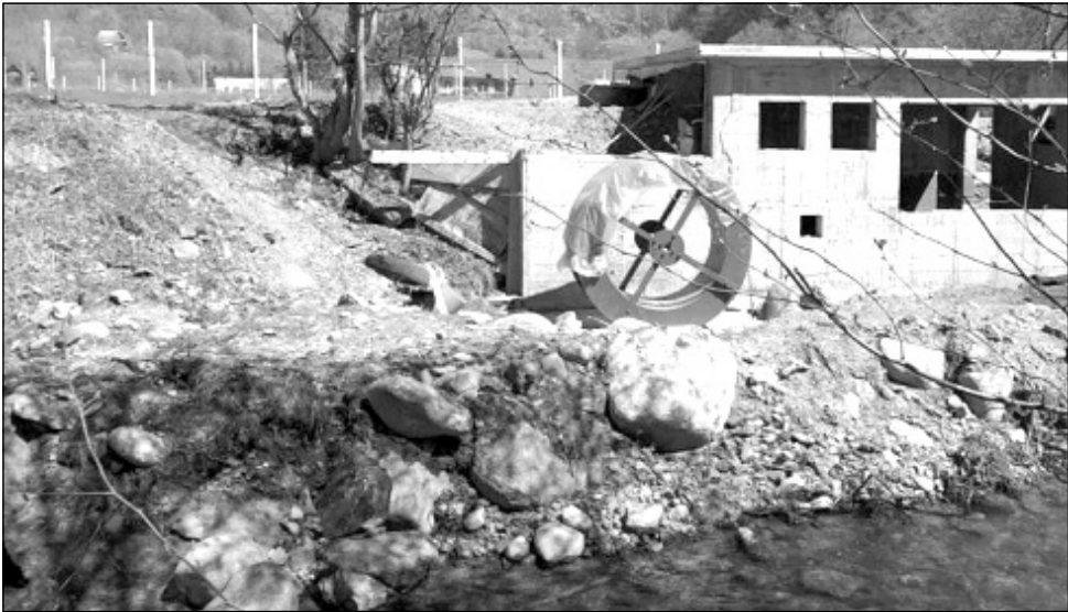
În albia râului Someșul Cald, s-a construit o microhidrocentrală, despre care autoritățile spun că nu au vreo informație
