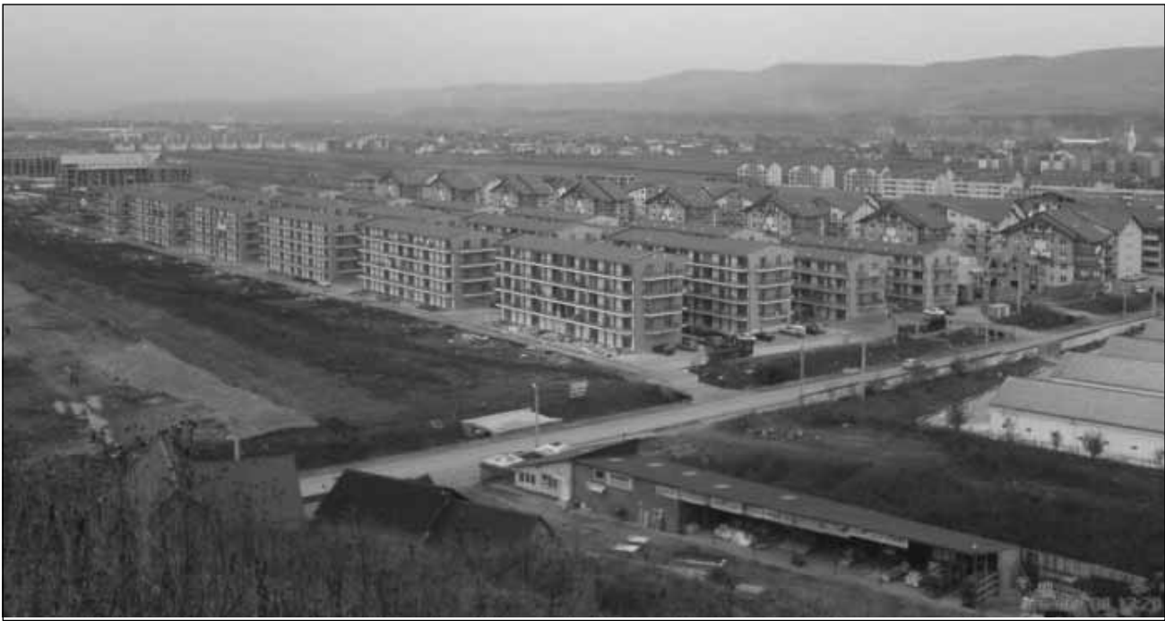
Multe dintre construcțiile din Florești au fost aprobate de autorități cu derogări importante de la Planul Urbanistic General
