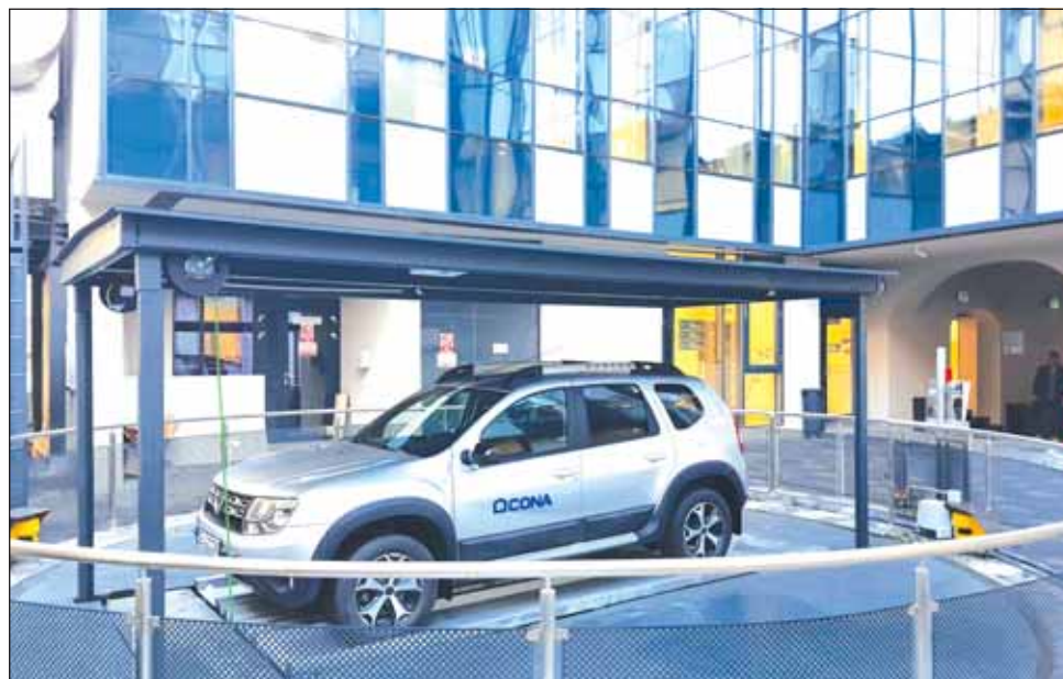
Parcarea este dispusă pe două niveluri subterane și are capacitatea de 15 locuri. Accesul se face pe o platformă rotativă situată la cota terenului amenajat, de unde mașina este preluată și transportată cu ajutorul unui lift în parcarea subterană până la locul de parcare disponibil.
