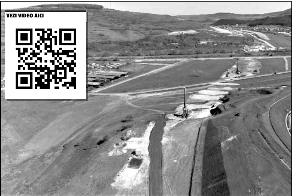
Lucrările pe tronsonul Nădășelu-Zimbor, de pe Autostrada Transilvania, sunt realizate în proporție de aproximativ 5%.
