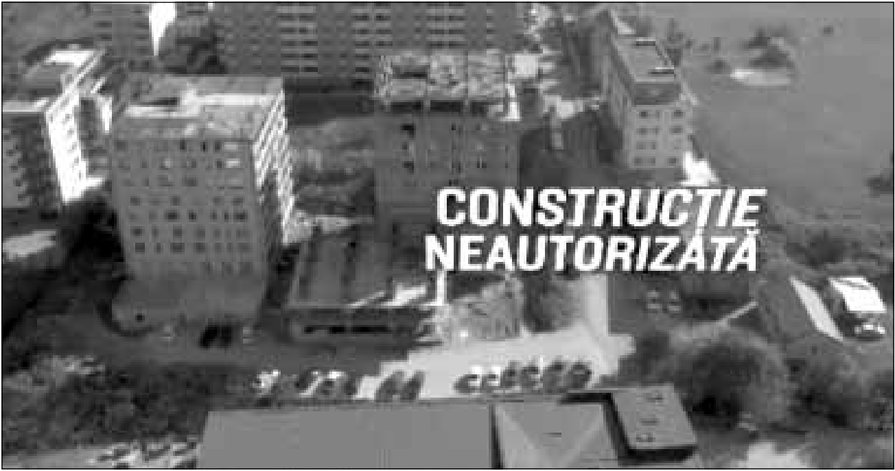
In 2009 Primăria a autorizat construcția a două blocuri, de opt etaje: unul de locuințe, celălalt de birouri
