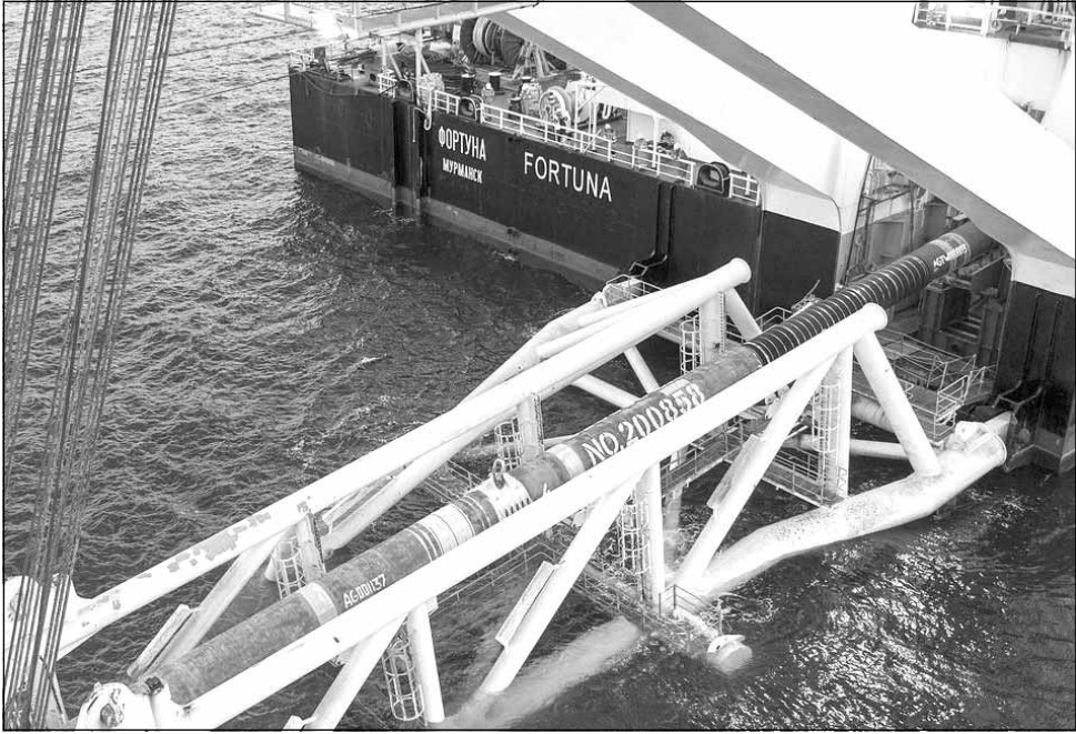
Grupul rus Gazprom a anunțat finalizarea lucrărilor de construcție la gazoductul Nord Stream 2
