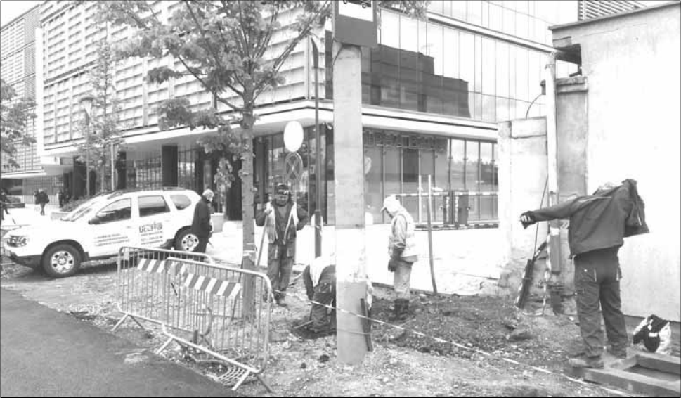
Au început forajele pentru metrou și trenul metropolitan, pe șantierul de pe Bulevardul 21 Decembrie
