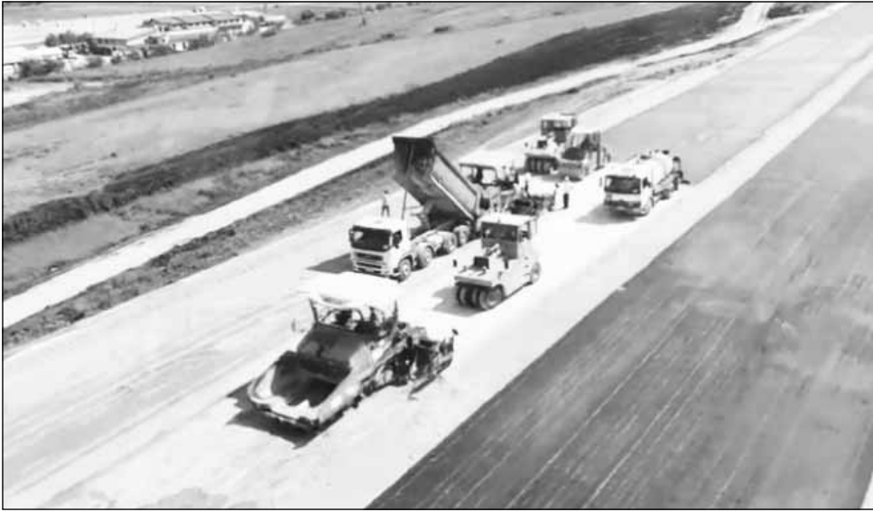
Dacă Răzvan Cuc a dat asigurări că Lotul 1 al Autostrăzii Sebeș-Turda va fi gata până la sfârșitul anului, lotul 2 este departe de a fi gata
