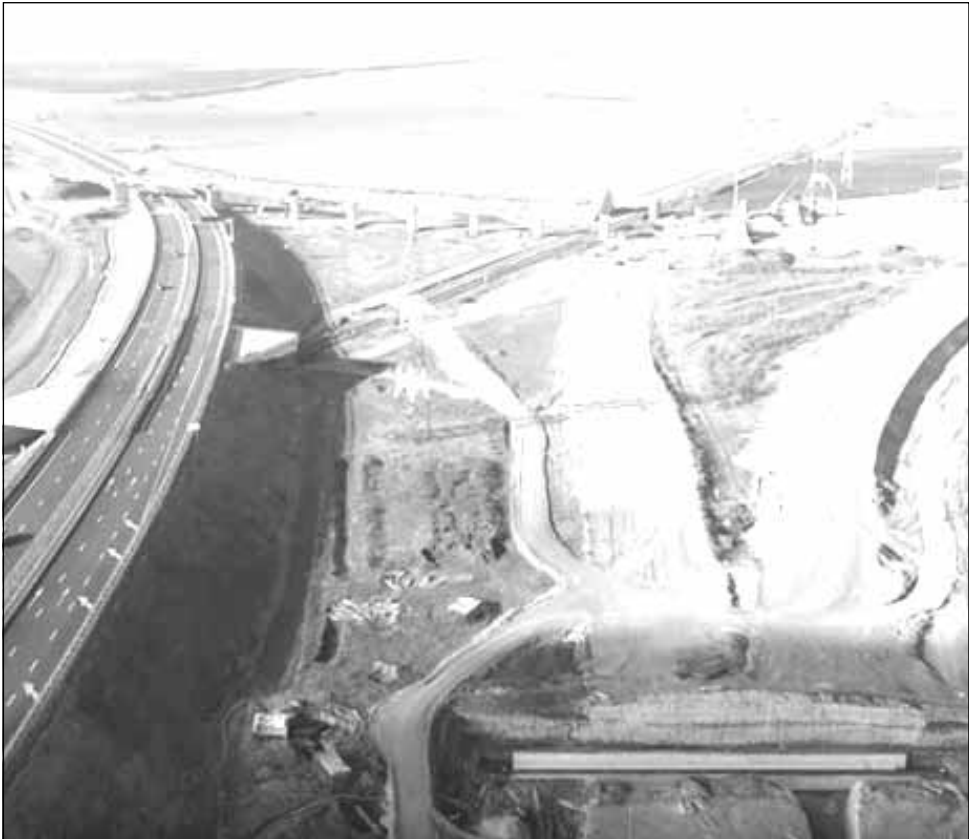
Lucrările de pe Autostrada Sebeș-Turda sunt în întârziere
