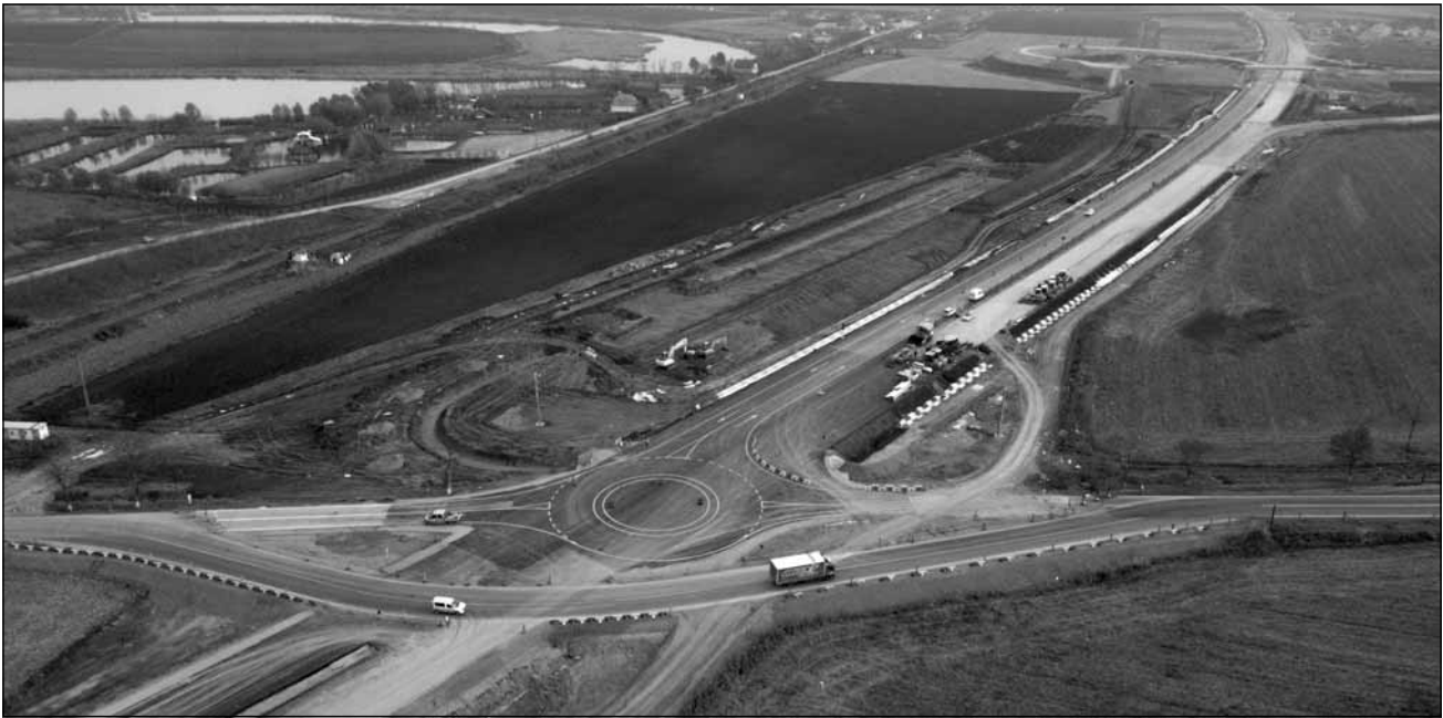
Lotul de autostradă Ogra – Iernut are o lungime de 3,6 km
