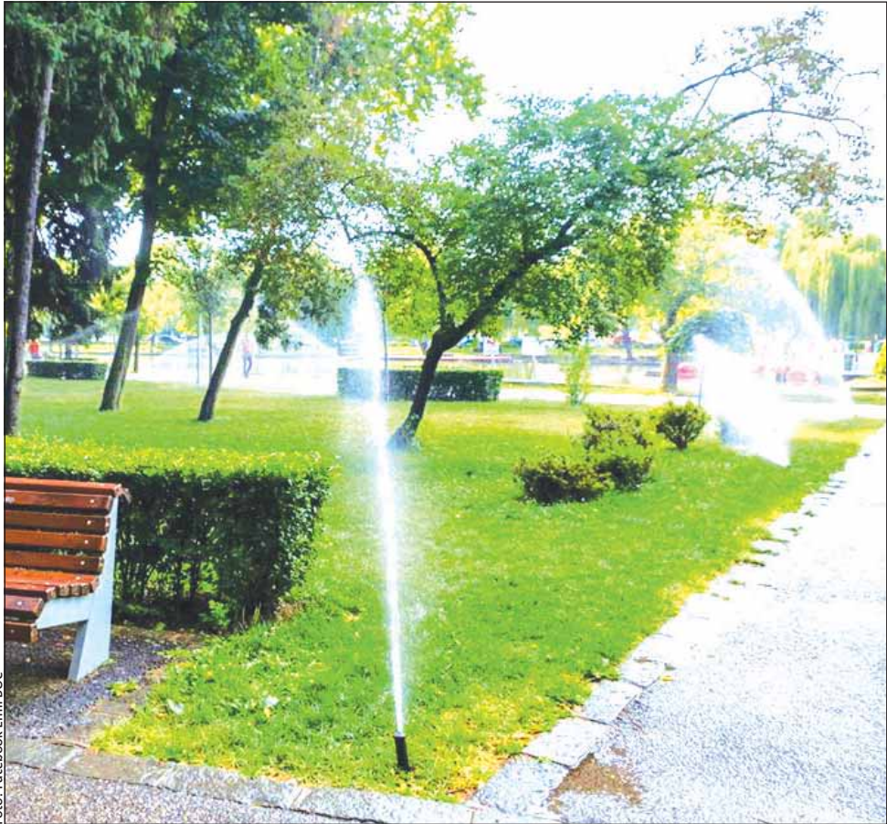
Lucrările de instalare a noului sistem de irigații din Parcul Central au fost finalizate
