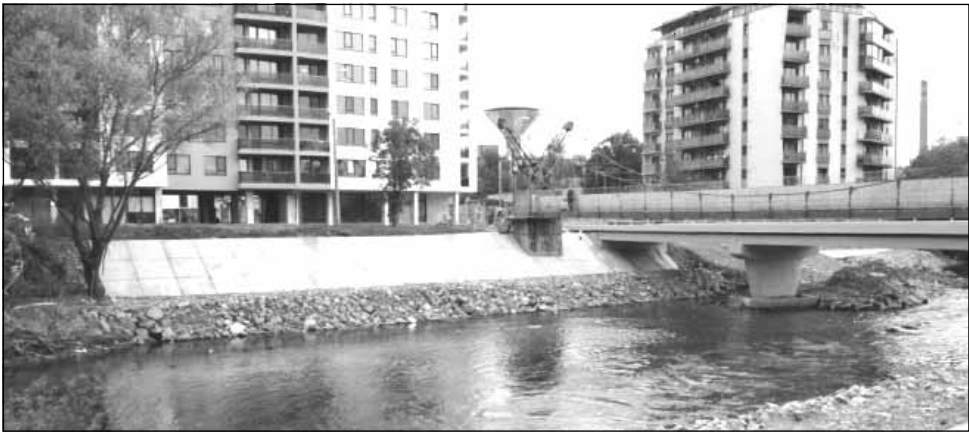
Constructorii au asistat intervențiile de la Podul Porțelanului după ce au descoperit un zăcământ de sare.
