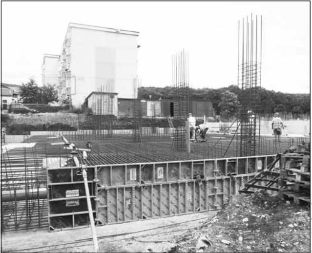
În iunie 2015, șantierul era în stadiul de 40%. Acum este la fel
