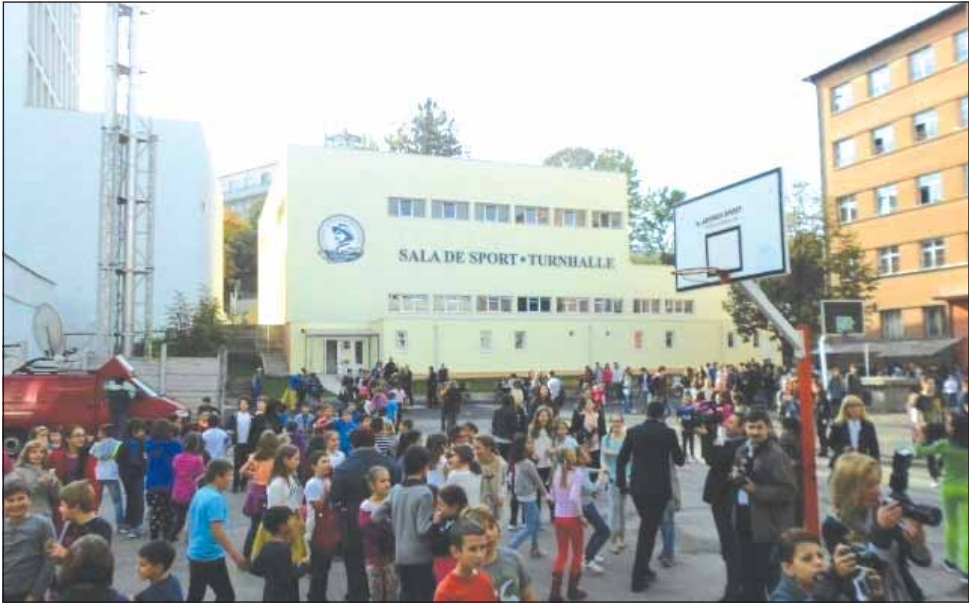
Închisă de mai bine de un an pentru că o grindă de susținere a tavanului s-a fisurat, sala de sport urmează să fie consolidată și redată elevilor.
