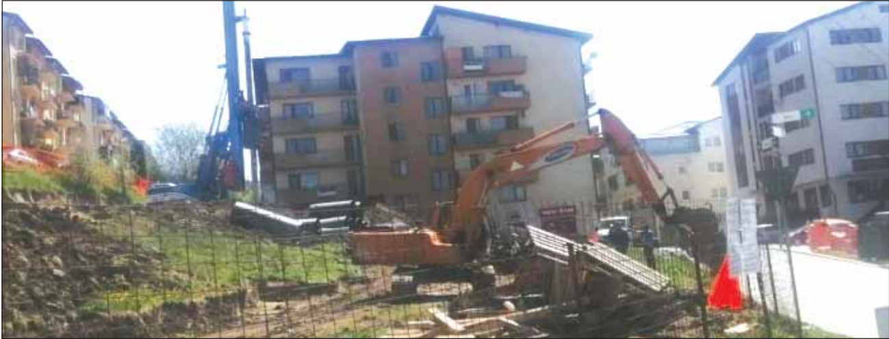
Pe strada Stejarului se sapă inclusiv sub balcoanele oamenilor, însă cei din cadrul Primăriei spun că săpăturile sunt făcute pentru consolidarea blocurilor
