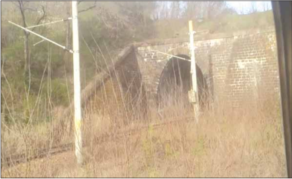
Proiectul din sectorul feroviar vizează reabilitarea structurilor de cale ferată aparținând Regionalei CFR Cluj
