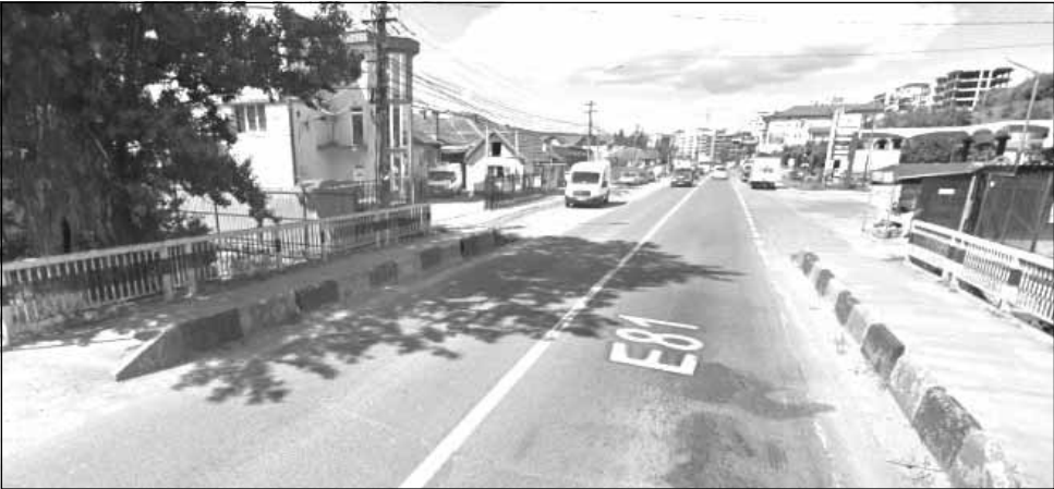
CNAIR are în vedere modernizarea și extinderea la patru benzi a drumului care conectează municipiile Cluj și Zalău
