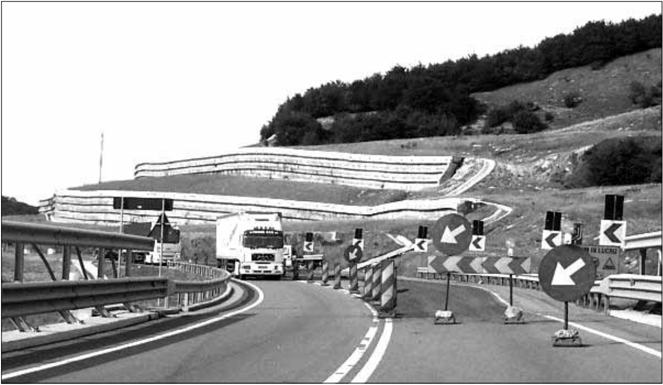
Șoferii pierd minute bune din cauza lucrărilor de pe șoseaua de centură a Clujului
