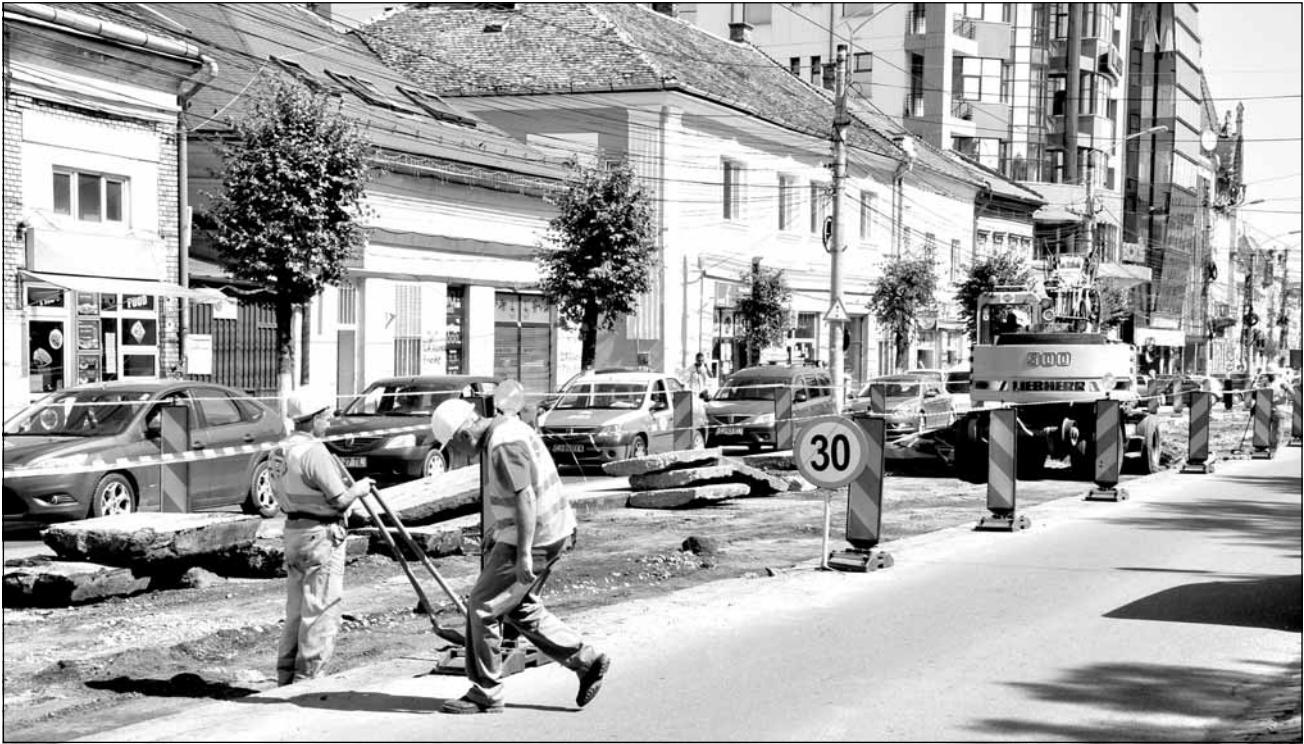
Lucrările de modernizare la linia de tramvai a ținut străzile principale ale Clujului în șantier timp de trei ani
