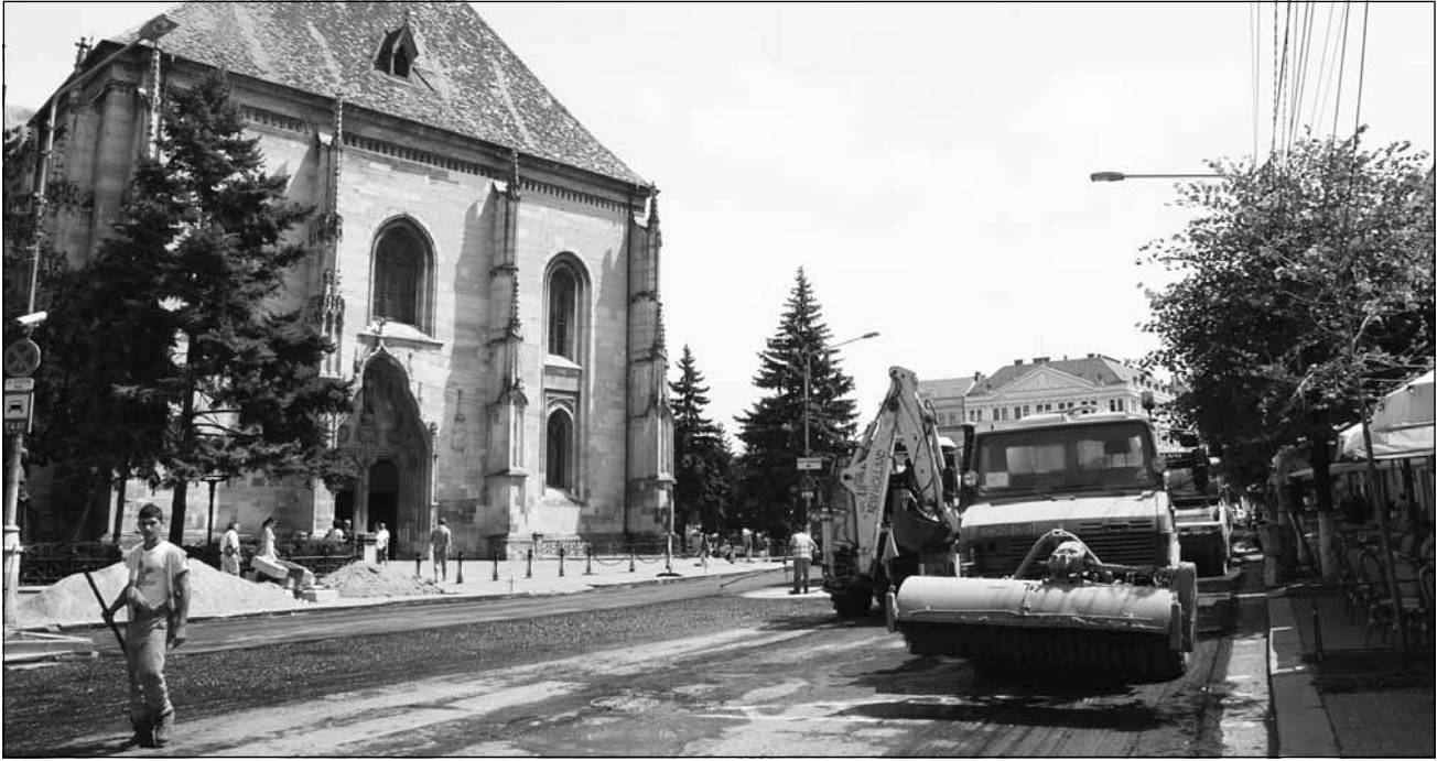
În Piaţa Unirii au fost realizate lucrări de modernizare
