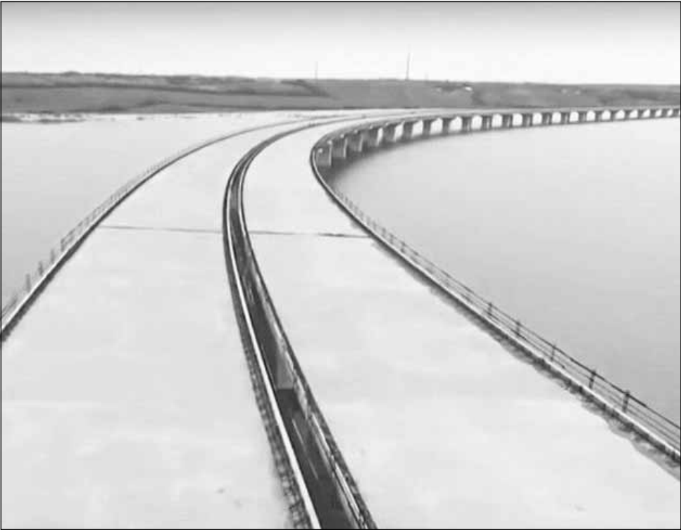
Vestitul viaduct de la Suplacu de Barcău de 1,8 km, un „muzeu în aer liber” pe Autostrada Transilvania între Zimbor și Poarta Sălajului, ordinul a fost suspendat
