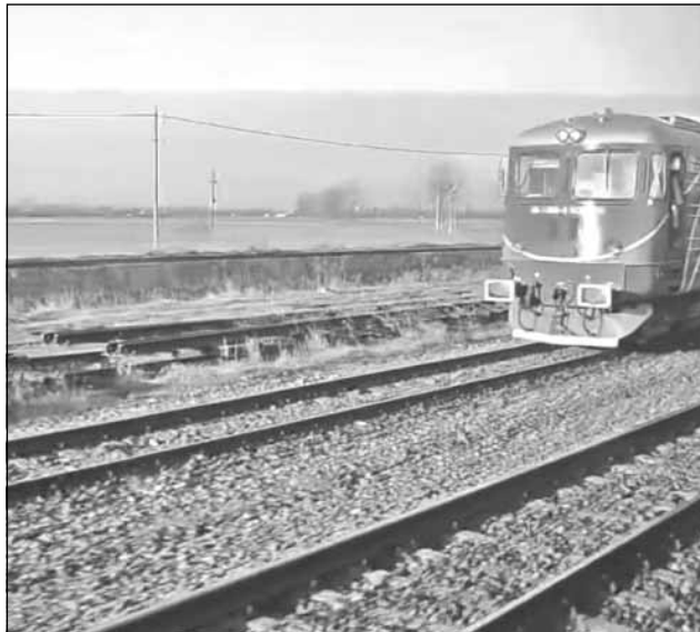
Modernizarea și electrificarea căii ferate Cluj-Napoca – Oradea – Episcopia Bihor este unul dintre marile proiecte de infrastructură feroviară
