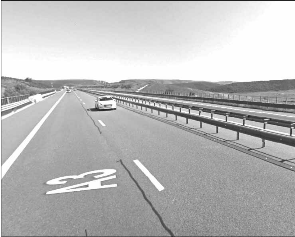
Drumul care va lega Autostrada Transilvania de DN1, asigurând o conexiune a Clujului cu A3, ar putea fi gata anul viitor
