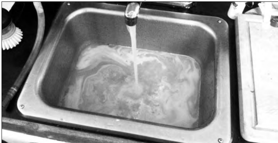
Toți locatarii de la blocuri vor beneficia, în perioada următoare, de contorizare individuală a apei
