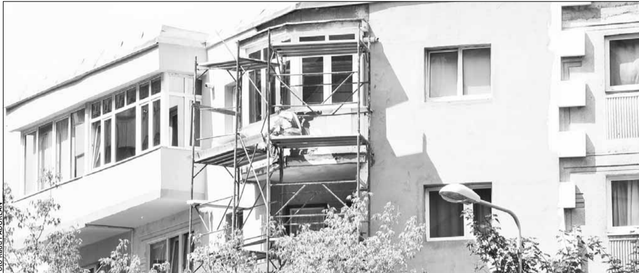
Lucrările de reparare sau închidere a balcoanelor au fost incluse în cadrul lucrărilor de reabilitare termică eligibile pentru contractarea creditelor cu dobândă subvenționată
