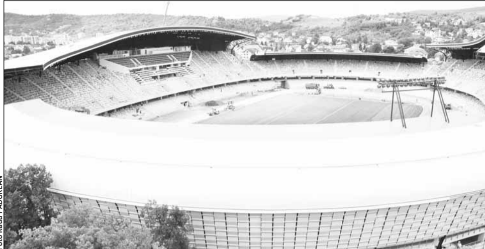
Noul stadion e aproape de finalizare, atât ca finisaje cât și ca și plată
