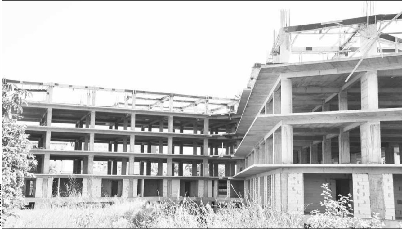
Foto: Radu PADUREAN Aici trebuia să fie un complex rezidențial cu apartamente și spații comerciale
